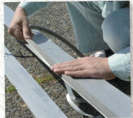
3 漏れ止めパッキンの貼付
