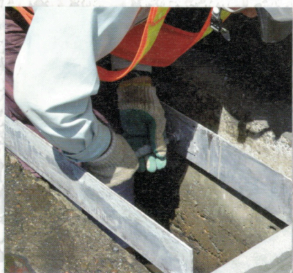
4 漏れ止め金具設置
