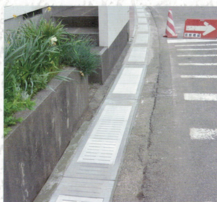
10 ECOンビ工法完了
