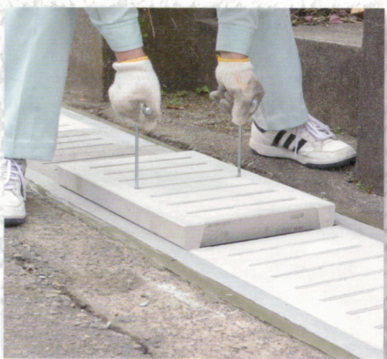
9 軽量二次蓋の設置
