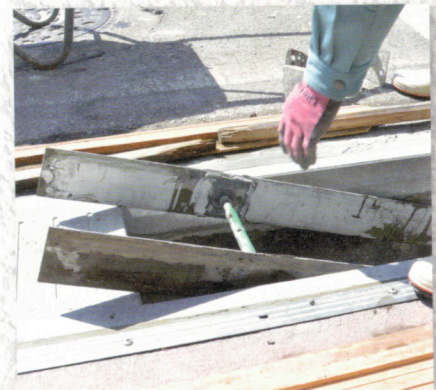
8 漏れ止め金具撤去
