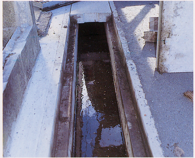
② 施工箇所の既設の蓋を取りはずす。
