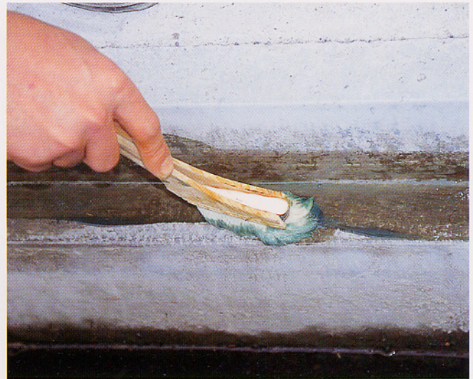
④ 接着剤をムラなく塗布する。
