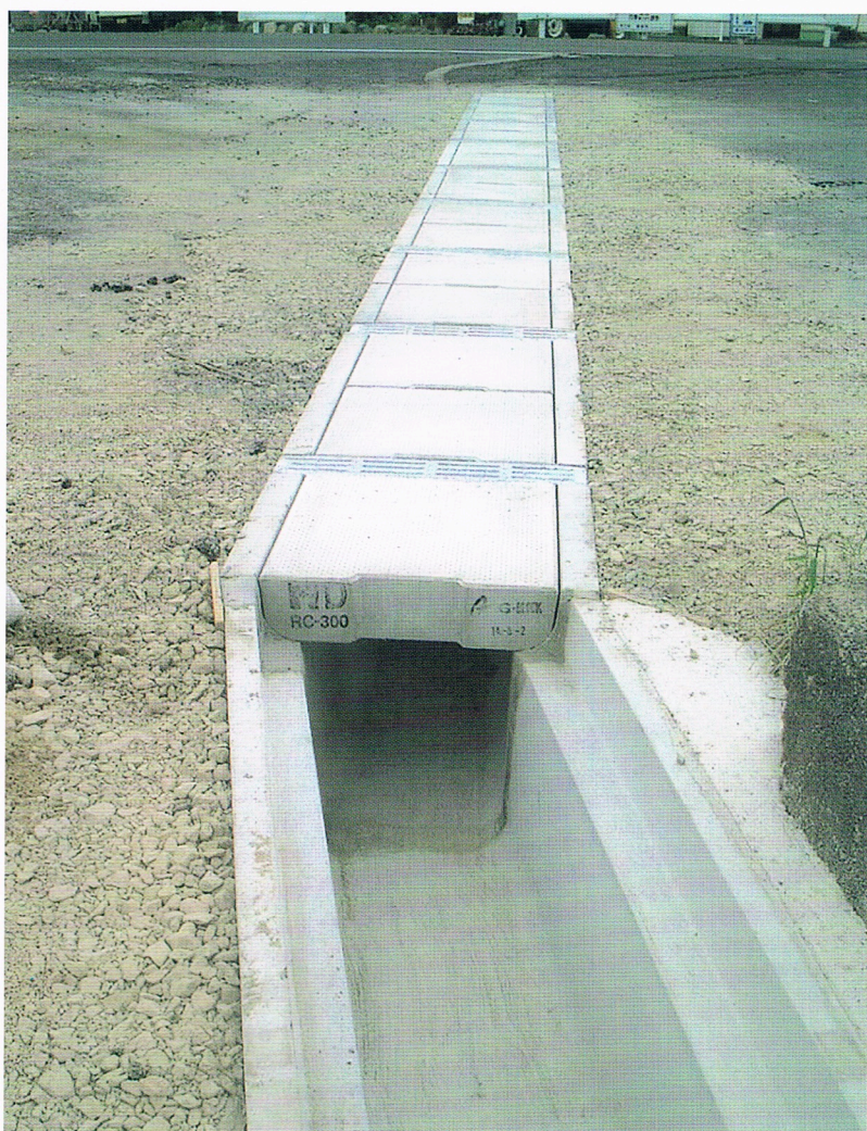
▲ ◀ アクアイン・グレーチング リボーン側溝に装着
